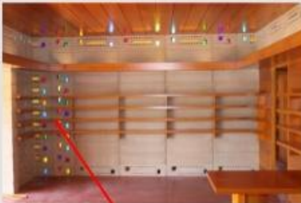
لغته داخلية للمبنى توضح استخدام الفتحات الصغيرة الملونة في الحائط الخرساني
