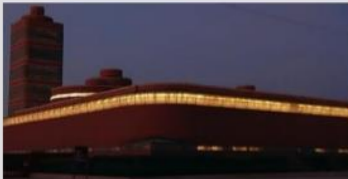
صور توضح الإضاءة الداخلية للمبنى
